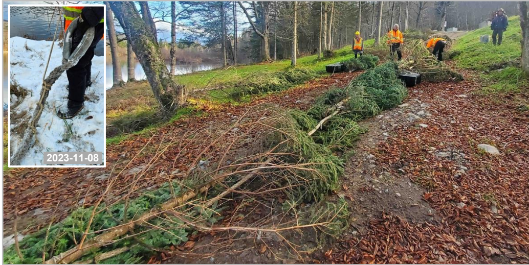
Figure 24 : Estacade flottante avec câble, sapins et flotteurs en plastique (12 novembre 2020).
