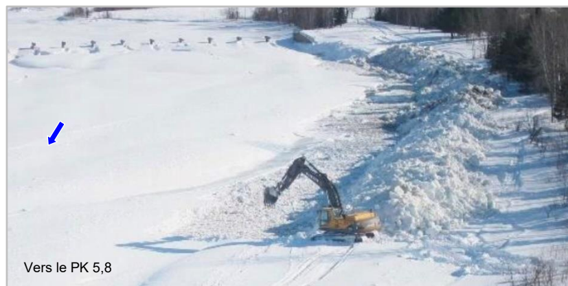
Figure 5 : Excavatrice conventionnelle travaillant à partir de la rive gauche, le 19 mars 2015.
