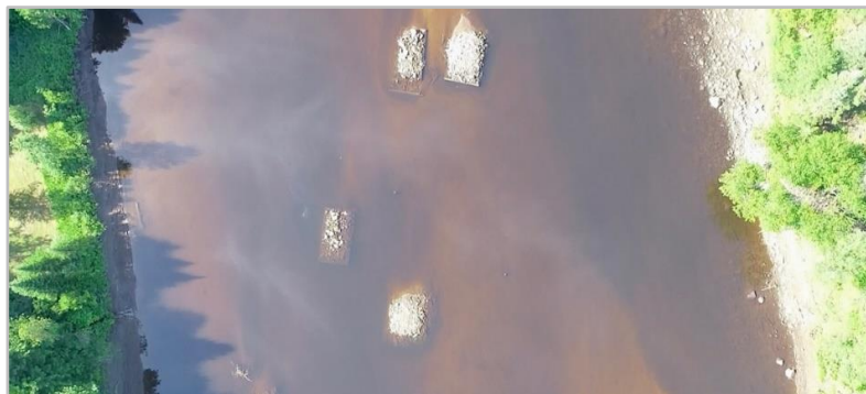
Figure 50 : Vue aérienne des caissons à la suite de l'abaissement du niveau d'eau, le 7 juillet 2020.
