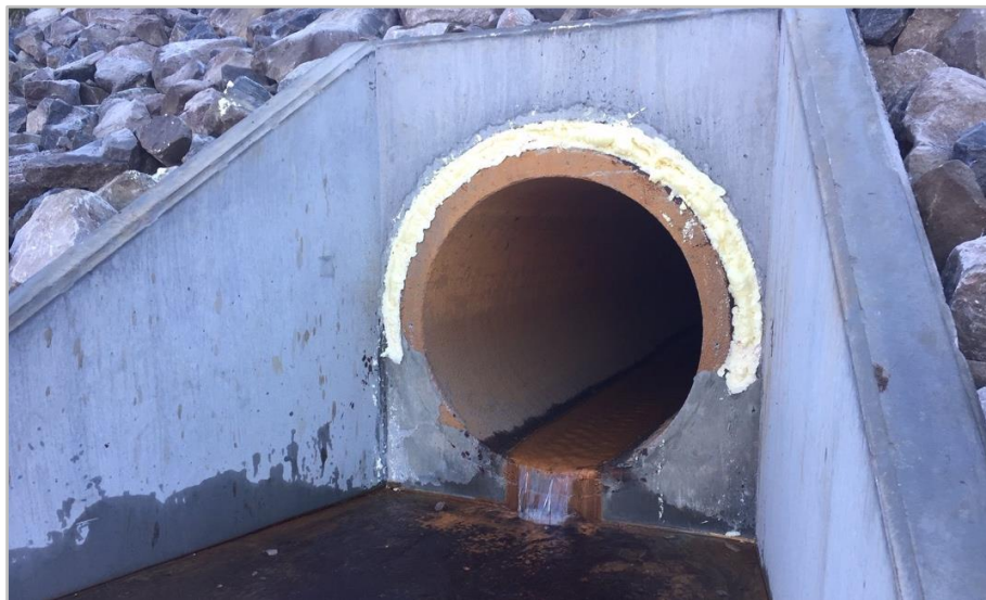
Figure 79 : Extrémité biseautée jointée avec du ciment et de la mousse d'uréthane, le 28 octobre 2021.
