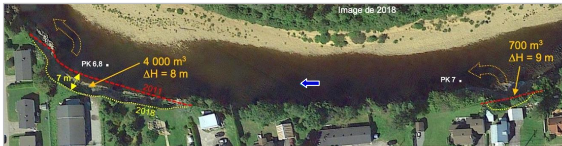
Figure 21 : Érosion et transport vers l'aval de matériel érodé entre 2011 et 2018, avant la stabilisation.
