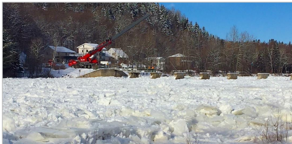
Figure 2 : Accumulation précoce de frasil dans la rivière Sainte-Anne le 15 novembre 2018, malgré l'opération des vannes par la grue.
