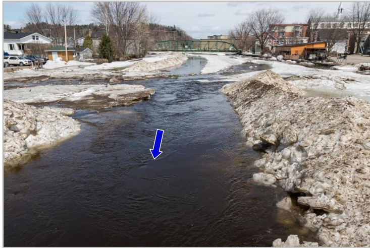
Figure 10 : Écoulement dans le chenal excavé au centre-ville permettant de maintenir les niveaux bas en préservant la faible revanche au centre-ville, le 21 avril 2019.
