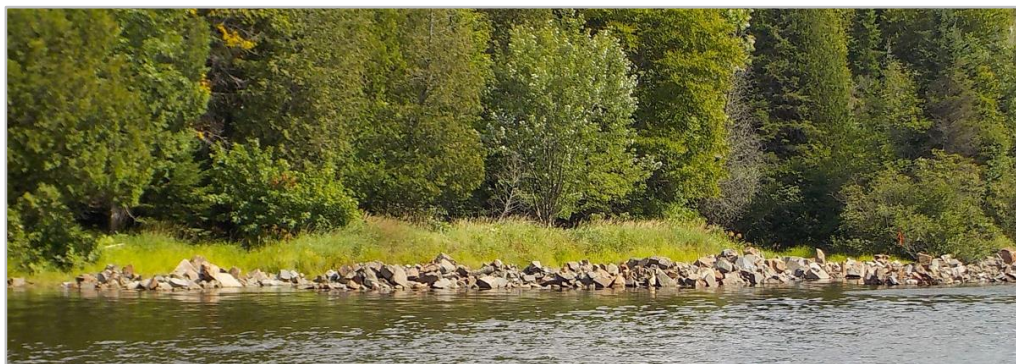
Figure 54 : Pierre des caissons confinée au bas de la rive (26 août 2020).
