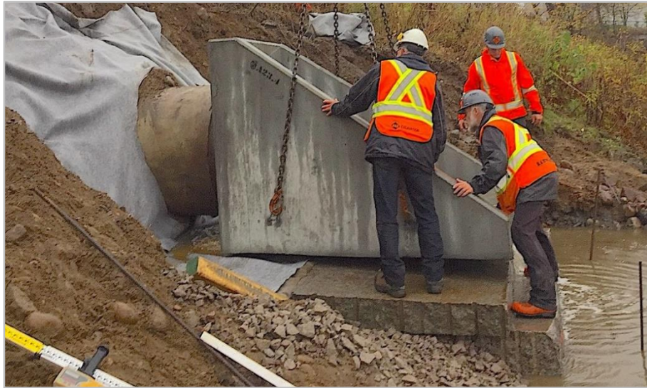
Figure 78 : Insertion de l'extrémité biseautée en béton le 21 octobre 2021.
