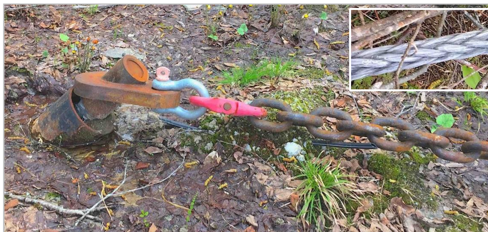
Figure 23 : Ancre, manille, joint fusible et chaîne. En médaillon, texture du câble sous tension.
