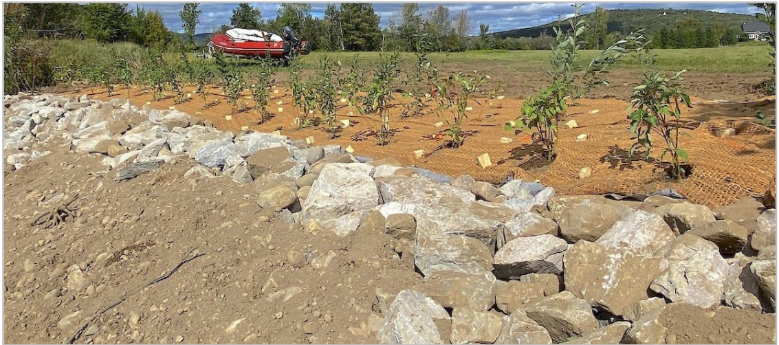
Figure 93 : Stabilisation et restauration de l'accès en rive gauche (16 septembre 2022)
