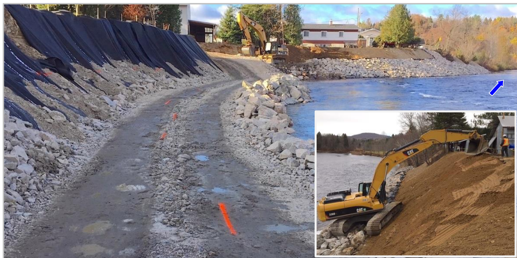
Figure 17 : Berme de travail aménagée sur une partie de l'enrochement (25 octobre 2018).
