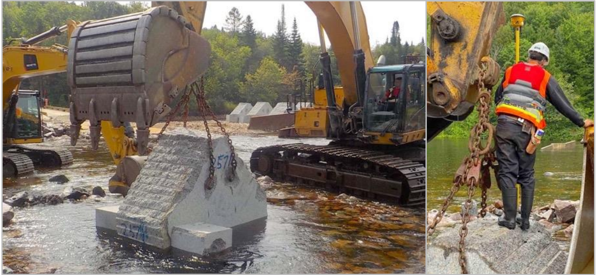
Figure 106 : Installation d'un bloc de taille avec deux excavatrices, dont l'une munie d'un DGPS. Validation de la localisation et de l'élévation des blocs de taille par un arpenteur.
