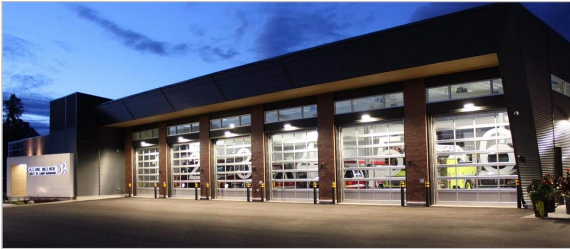
Figure 125 : Nouveau poste de pompier au n° 103, rang Grande Ligne (photo, site Web de la Ville).
