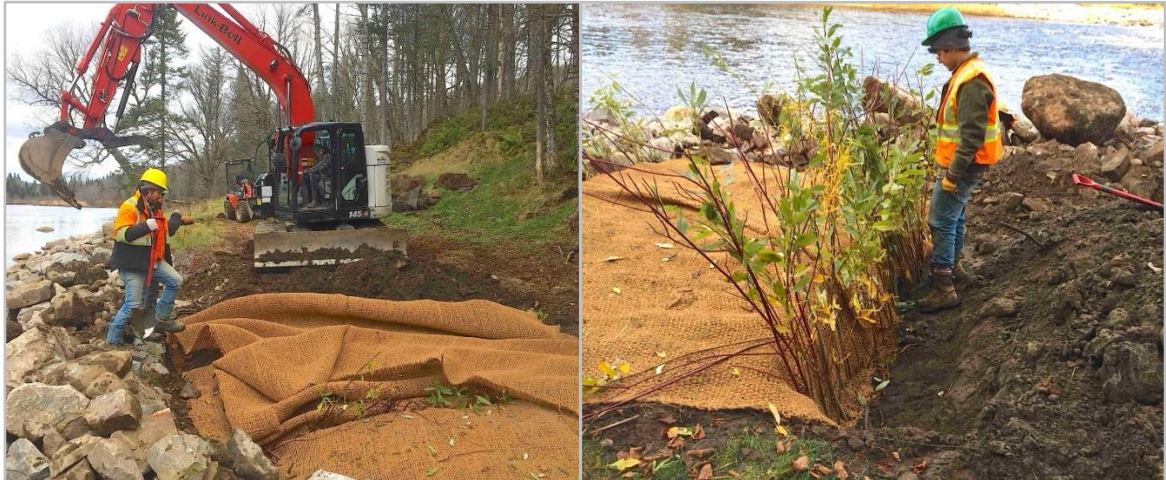
Figure 42 : Mise en place du BioD-Mat 90 et des rangs de plançons le 4 novembre 2021.
