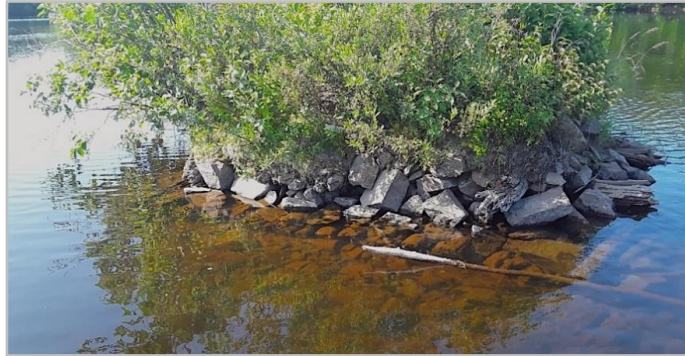
Figure 48 : Caisson de drave émergeant au-dessus de l'eau en août 2019.
