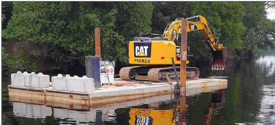
Figure 51 : Enlèvement des caissons avec l'excavatrice montée sur une barge (11 août 2020).
