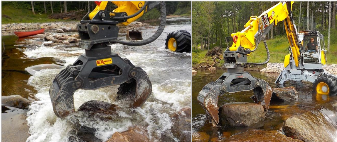
Figure 44 : Mise en place de quelques blocs rocheux au seuil du PK 24 le 19 août 2021.
