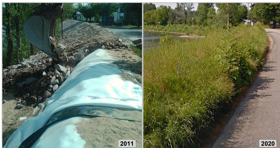
Figure 82 : Digue de la rive droite faite d'un enrochement et d'une géomembrane.
