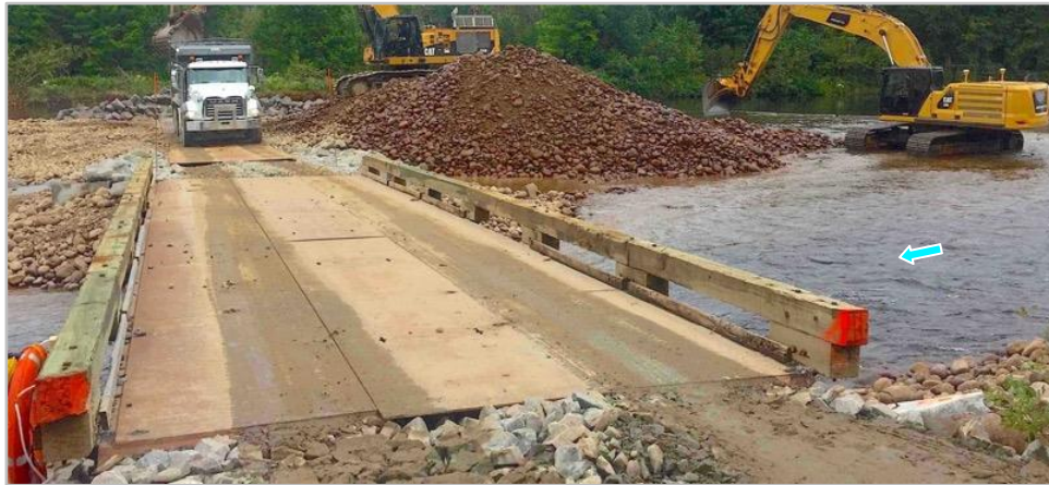
Figure 105 : Utilisation d'un pont temporaire en appui sur la rive gauche renforcée.
