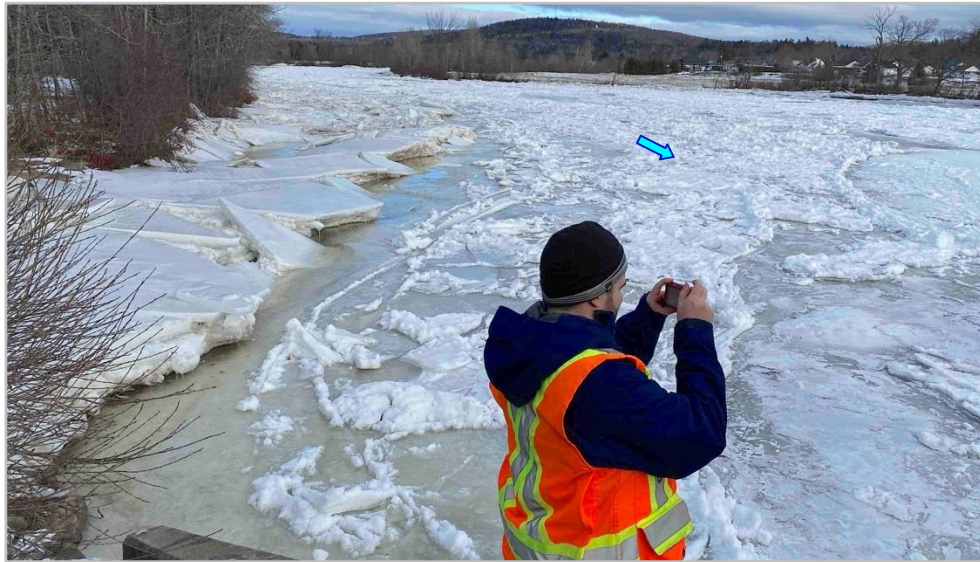
Figure 98 : Frasil dans le réservoir du barrage de Saint-Raymond, le 14 décembre 2022.
