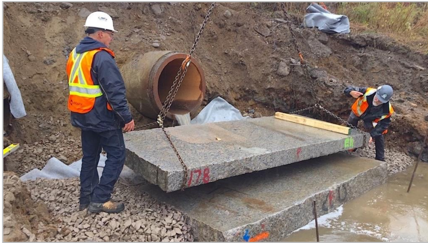
Figure 76 : Mise en place d'une troisième dalle de granite le 21 octobre 2021.
