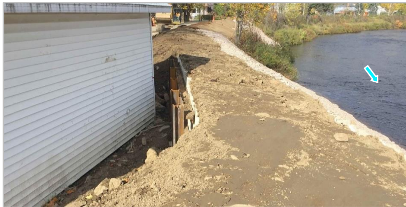
Figure 63 : Contrefort en acier appuyant la digue (8 octobre 2020).
