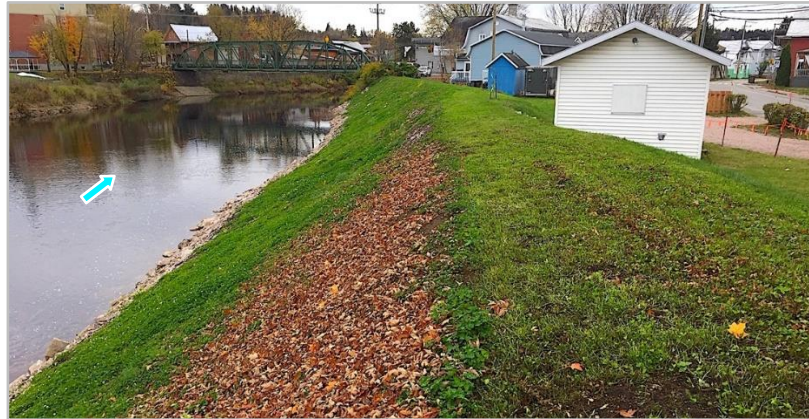
Figure 65 : Enrochement en partie végétalisé par le compost et les semences, le 21 octobre 2021.
