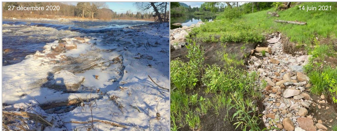
Figure 41 : Bris partiel du BioD-Mat et érosion du sol constatés en décembre 2020 et juin 2021.
