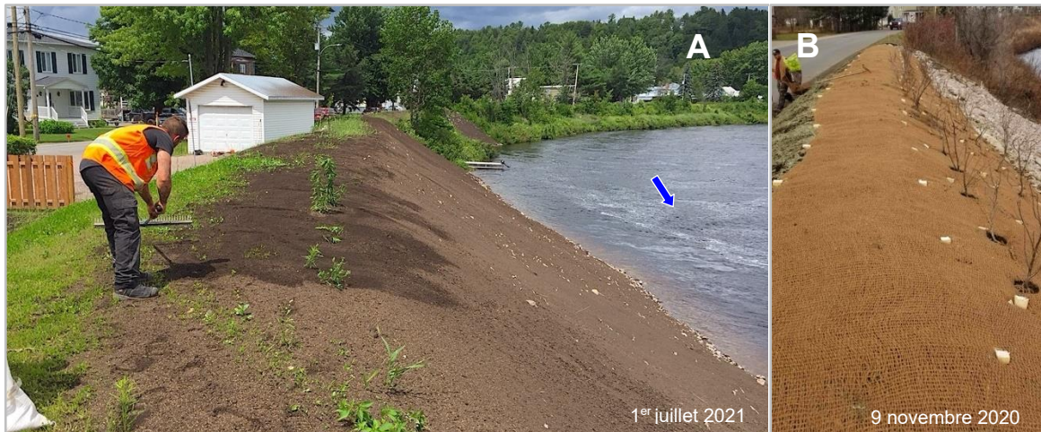
Figure 60 : En A, compost et semences. En B, BioD-Mat et plantation sur la partie amont de la digue.
