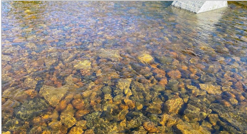
Figure 112 : Galets arrondis mis en place sur le matelas de pierre (8 septembre 2022).
