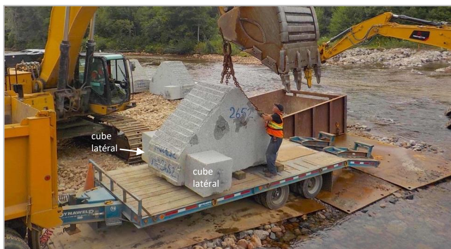
Figure 101 : Levage d'un bloc de taille avec une excavatrice de 74 tonnes (25 août 2022).
