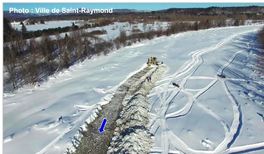
Figure 9 : Dégagement d'un chenal dans la glace de la rivière Sainte-Anne par la pelle-araignée, le 22 janvier 2019.
