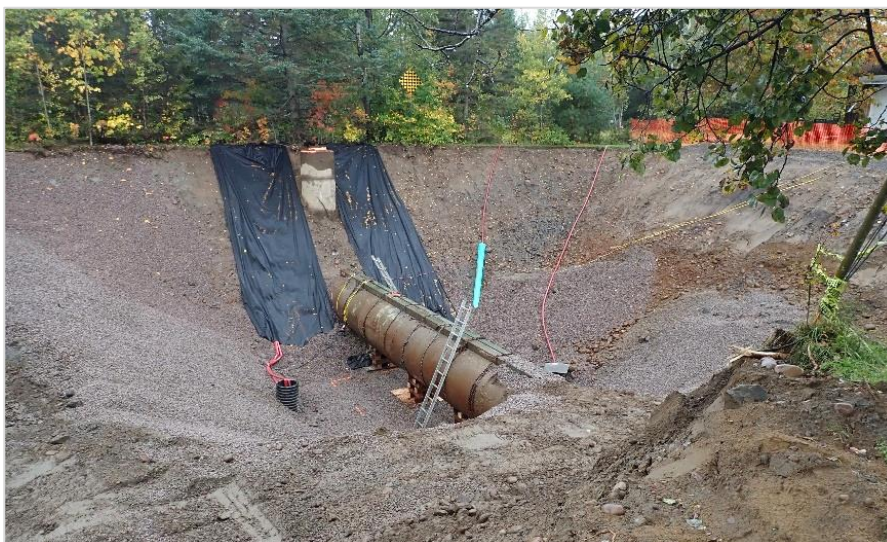
Figure 72 : Dégagement de la conduite pluviale lors des travaux le 2 octobre 2020.
