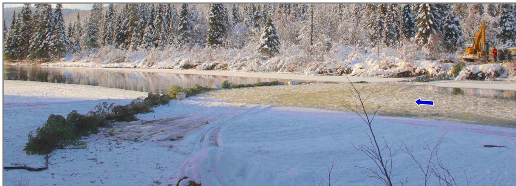
Figure 25 : Estacade de rétention du frasil fait d'un câble flottant et d'épinettes (9 décembre 2016).
