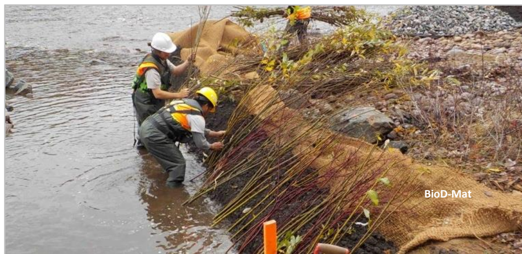
Figure 108 : Mise en place des rangs de plançons de saules et de cornouiller (26 octobre 2022).
