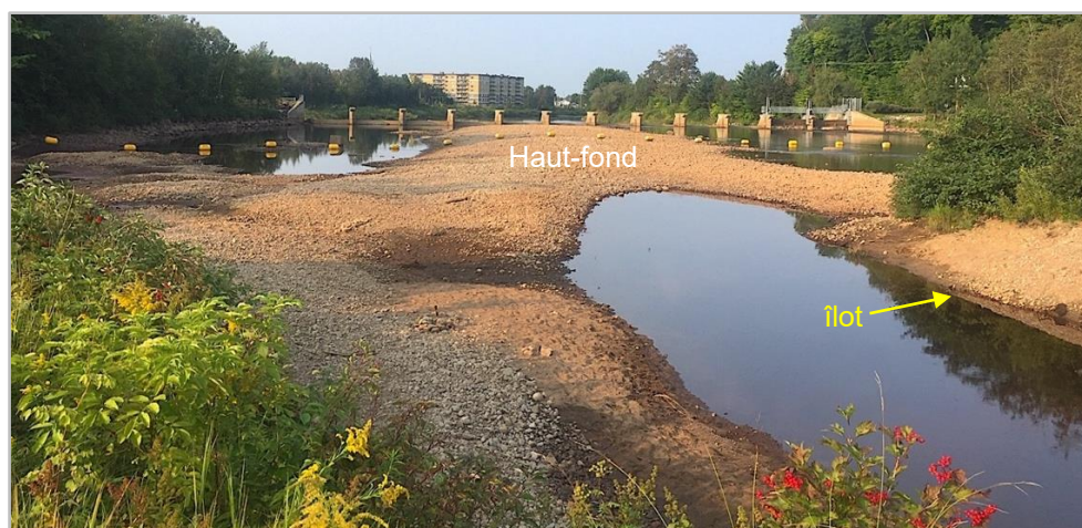
Figure 89 : Haut-fond visible après l'abaissement du niveau d'eau du réservoir (10 août 2021).
