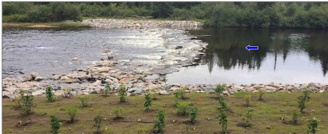
Figure 30 : Seuil de blocs rocheux destiné à réduire la vitesse de l'écoulement (5 septembre 2020).
