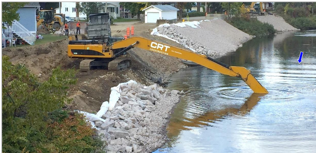
Figure 57 : Creusage d'une clé par une excavatrice munie d'un bras de 26 m, le 23 septembre 2020.
