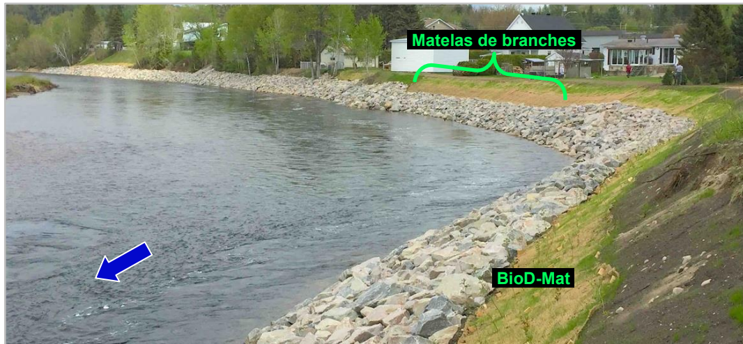
Figure 20 : Talus riverain de 394 m stabilisé. Photo prise vers la fin de la crue, le 29 mai 2019.
