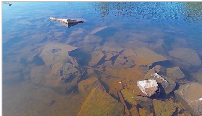
Figure 49 : Pierres d'un caisson de drave en partie démantelé et sous l'eau en août 2019.
