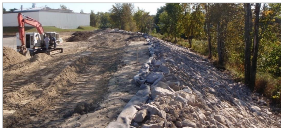
Figure 83 : Construction de la digue avec enrochement et noyau d'argile en rive gauche, en 2009.
