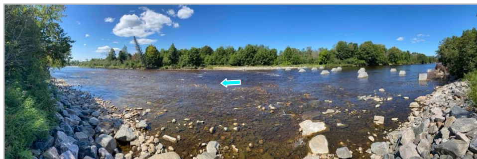
Figure 114 : Photo panoramique du SRG et de son rapide en aval, le 28 août 2023 à 29 m 3 /s.
