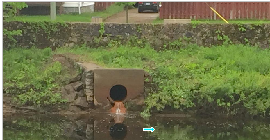
Figure 75 : Émissaire et mur de tête haut de 2,4 m vus de la rive opposée, le 19 juin 2019.
