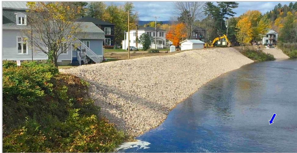
Figure 59 : Enrochement recouvert de gravier afin de favoriser sa végétalisation le 8 octobre 2020.
