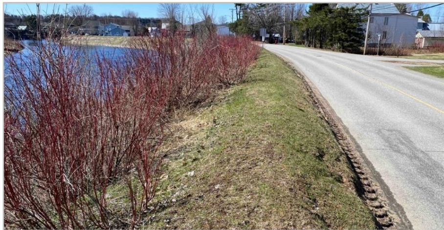
Figure 85 : Digue de la rive droite avec des cornouillers du côté de la rivière (25 avril 2024).
