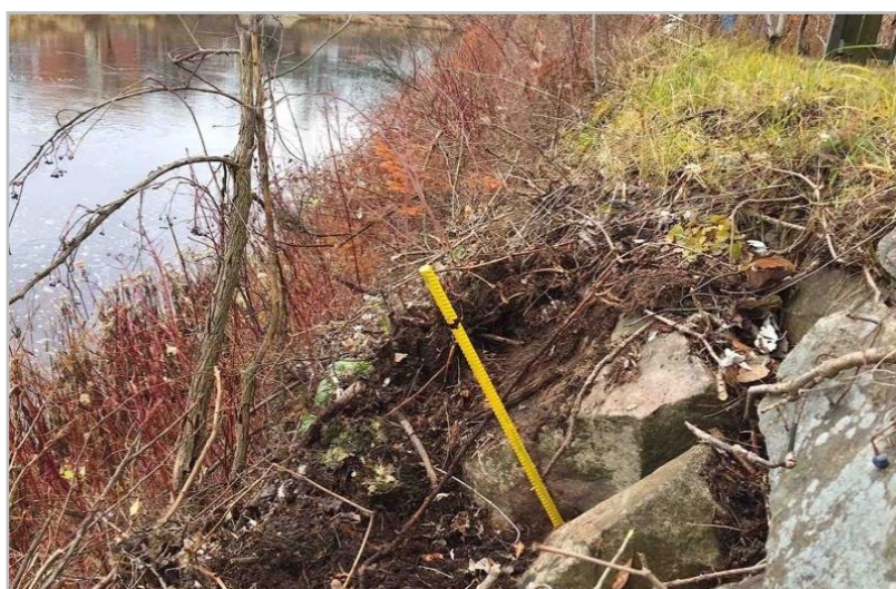
Figure 55 : Cavités dans l'ancienne digue en pierre vers le PK 5,4.
