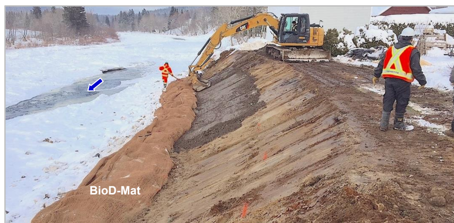
Figure 19 : Travaux d'amendement du sol sous le matelas de branches, le 19 novembre 2018.
