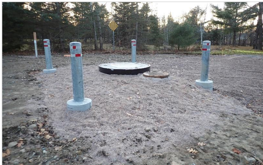
Figure 73 : Clapet Jacques-Labranche, le 12 novembre 2020, avant la complétion des travaux de végétalisation au printemps 2021.
