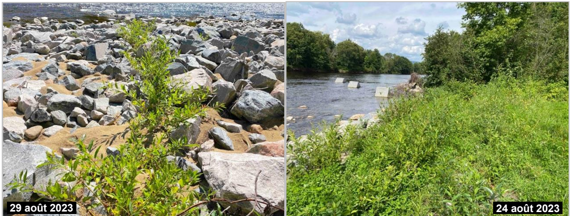
Figure 121 : Reprise de la végétation en rive, incluant les rangs de plançons, durant l'été 2023.
