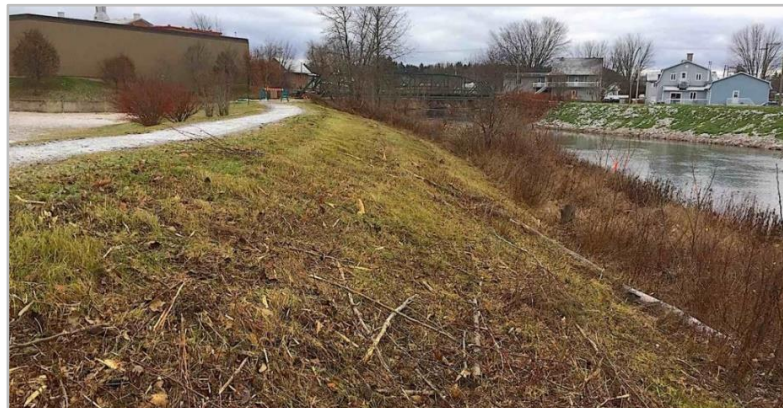
Figure 87 : Défrichage de la digue de la rive gauche le 16 novembre 2021.
