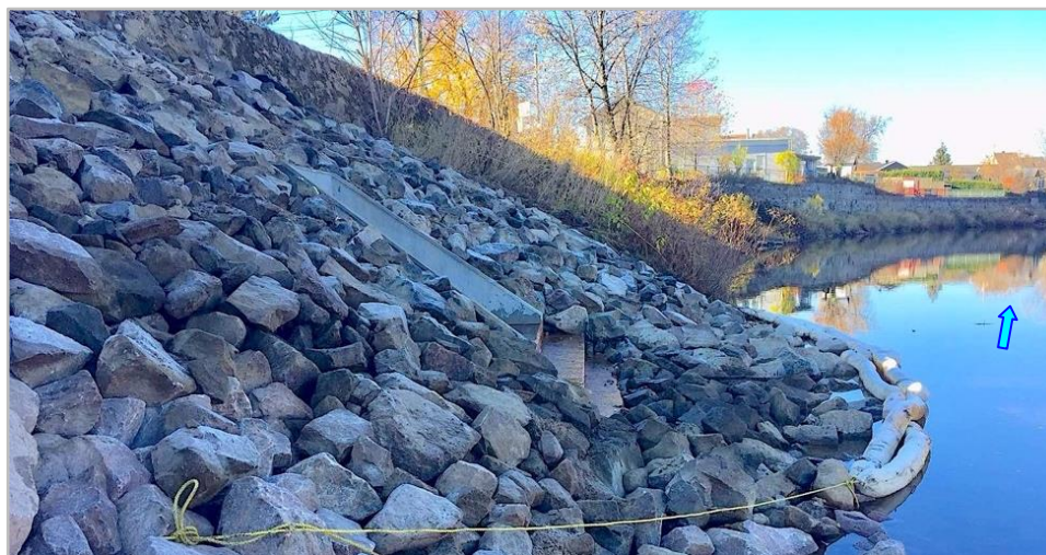
Figure 80 : Nouvel émissaire avec EBF sans saillie en rive, le 28 octobre 2021.
