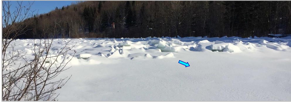
Figure 99 : Embâcle naturel au PK 10,5 avant l'aménagement du SRG (photo du 9 janvier 2020).
