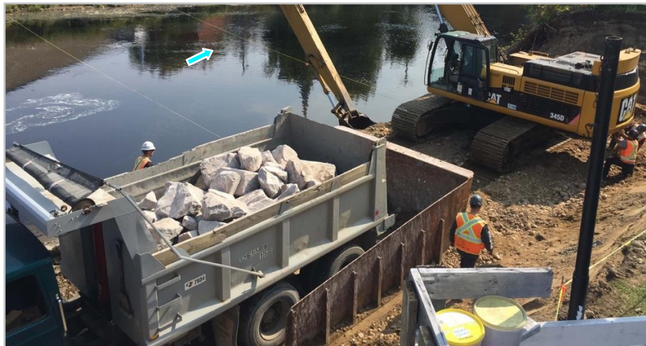
Figure 64 : Boîte en acier pour éviter de mélanger de la terre avec la pierre. Cette mesure accélère aussi la réalisation des travaux et limite la durée de leur impact.
