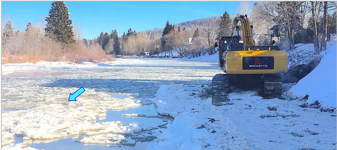
Figure 18 : Apport de frazil ayant ralenti des travaux le matin du 15 novembre 2018.
