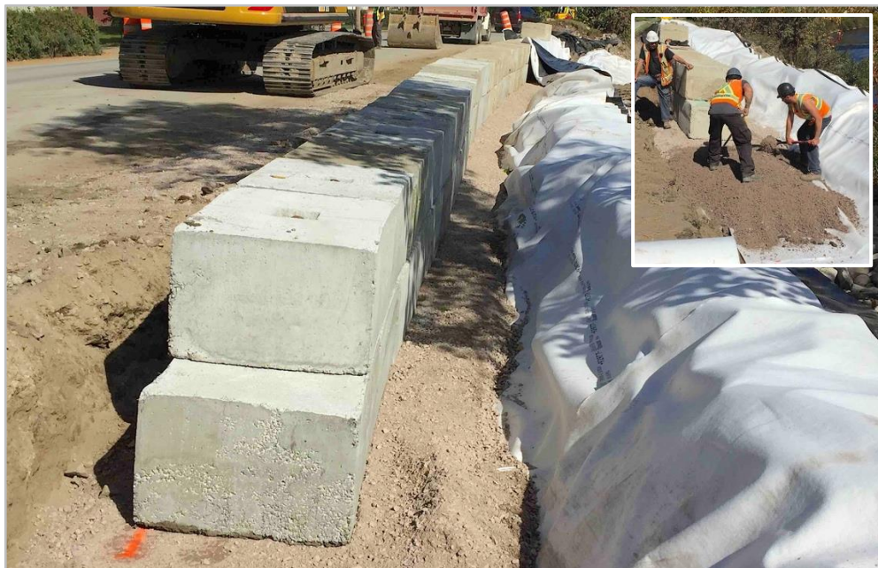
Figure 62 : Digue anti-débordement en construction le 25 septembre 2020.
